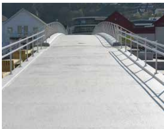
Gangbru i Flekkefjord belagt med Plexigulv® Heavy load, april 2019.
